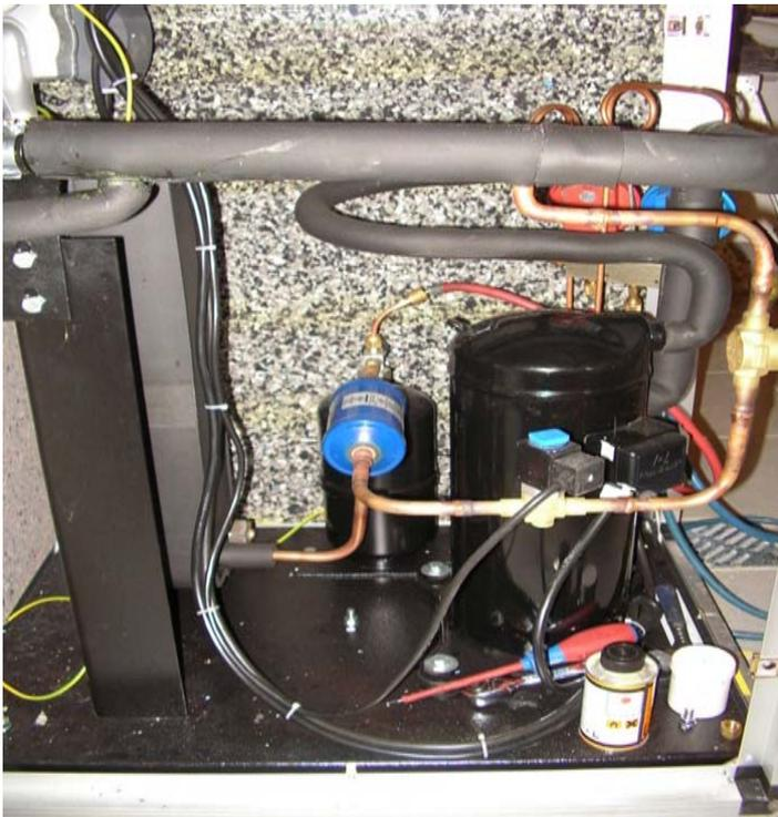
Wärmepumpe ohne Verdampfer
