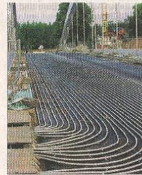
6300 Meter Heizrohre wurden während des Baus im Brückenasphalt verlegt.
