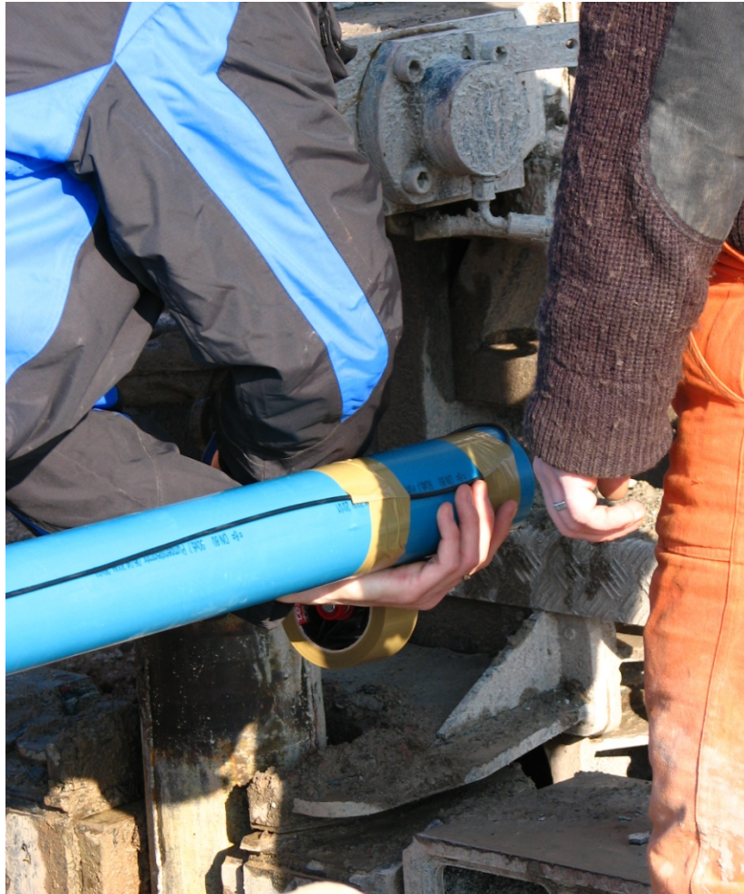
Installation des DTS-Systems
