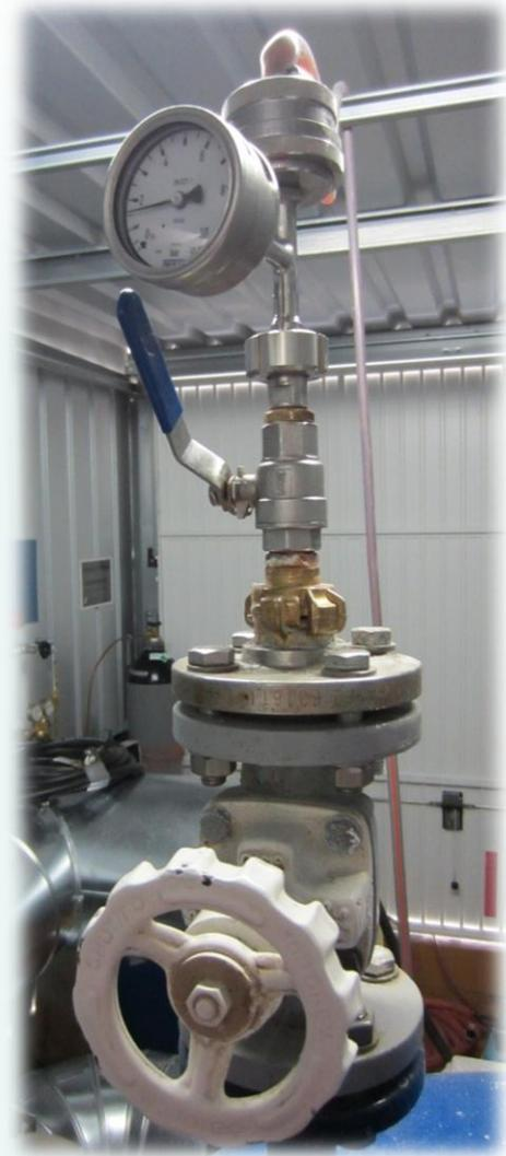
Filtrationseinheit mit manuellem Druckregler
